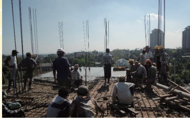
人数の多い建設現場
